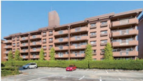
〈最も傾斜が大きかった4号棟、杭が損傷し、建物が傾斜〉
